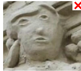
⊘ потеря пластики декора из-за многослойных окрашиваний и (или) окрашиваний без восполнения дефектов элементов декора
