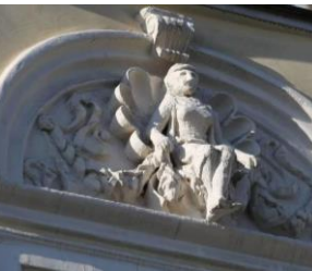
⊘ потеря пластики декора из-за многослойных окрашиваний и (или) окрашиваний без восполнения дефектов элементов декора
